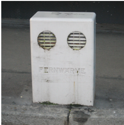
Belüftungskasten Fernwärme
