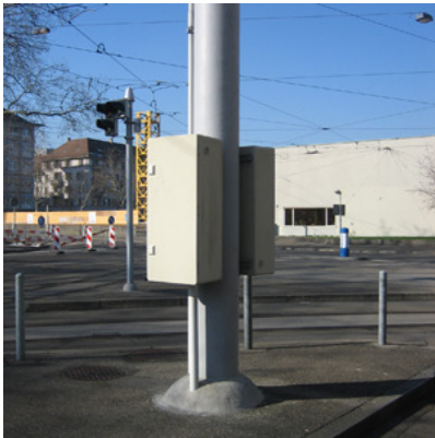
Weichensteuerkasten VBZ
