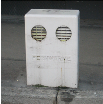
Belüftungskasten Fernwärme
