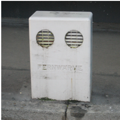
Belüftungskasten Fernwärme
