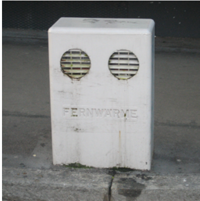
Belüftungskasten Fernwärme
