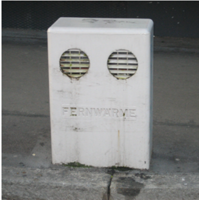
Belüftungskasten Fernwärme
