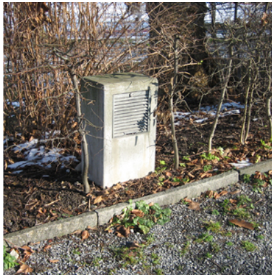
Belüftungskasten Swisscom
